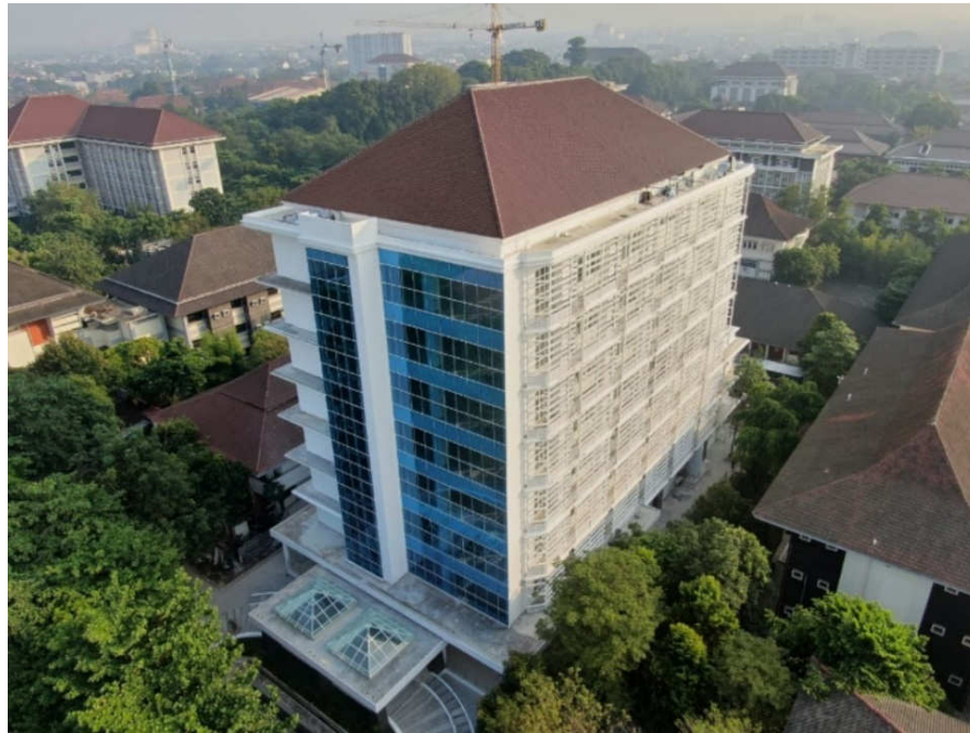
Gambar 2.2 Proyek Pembangunan Gedung APSLC Universitas Gadjah Mada (Sumber: Dokumentasi Proyek)
