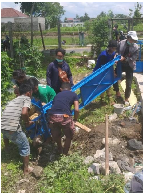
Lampiran 8. Pemasangan Pintu Air
