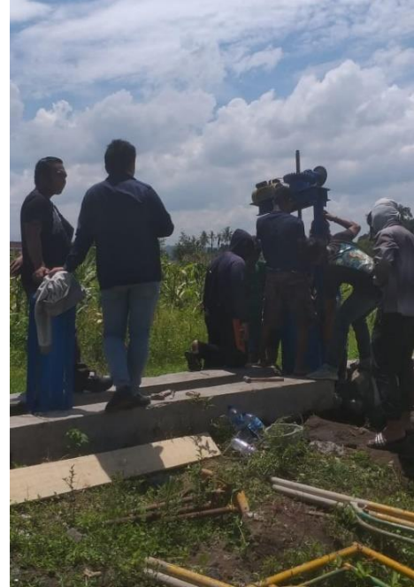
Lampiran 7. Pemasangan Pintu Air
