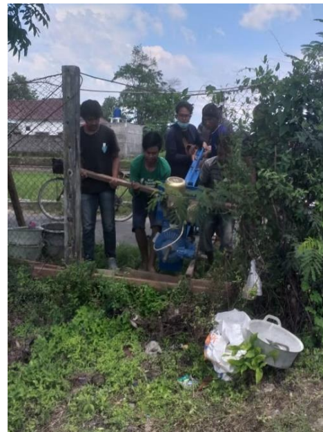
Lampiran 9. Pemasangan Pintu Air
