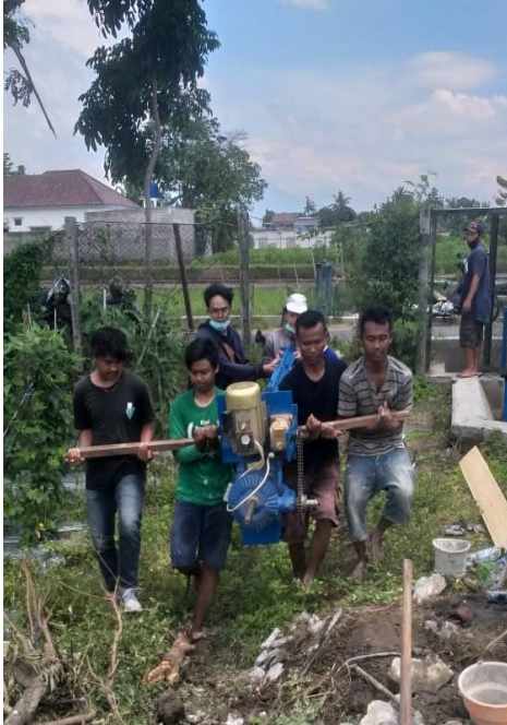
Lampiran 6. Pemasangan Pintu Air
