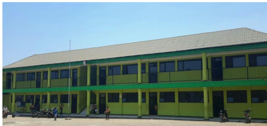
Gambar 3.1-3. Gedung SD dan SMP
