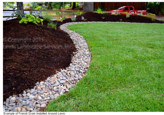
Gambar 76 detail French drain dan contoh bagian permukaannya http://www.lewislandscape.com/drainage.html diakses pada 10 Desember 2015
