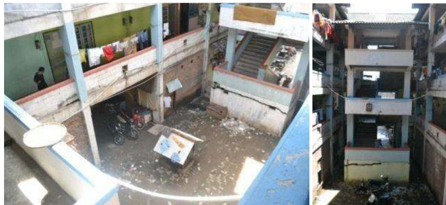
Gambar 2.8 Tampilan Bangunan Rumah Susun Bandarharjo
