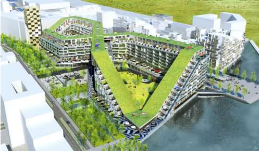
Gambar L.1 Eksterior bangunan 8 House
