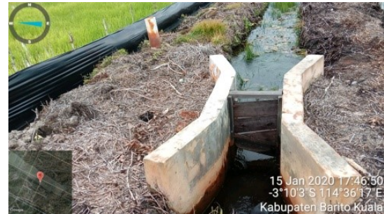
Pintu air saluran quarter
