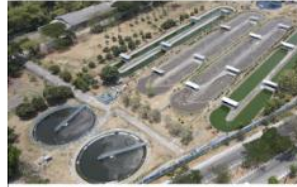
Instalasi Pengolahan Air Limbah (IPAL) Menerima dan mengolah air limbah industri maupun domestik hingga kapasitas 10.000 m 3 /hari (Surabaya) dan 14.000 m 3 /hari (Pesururan).
