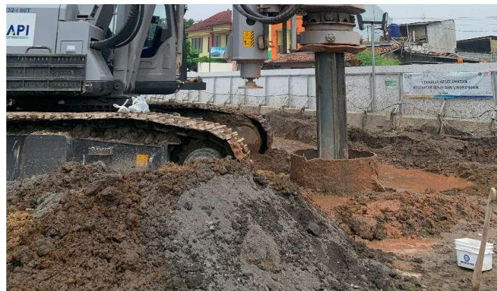
Gambar 4. 2 Pengeboran fondasi Bored Pile
