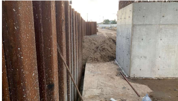
Gambar 4. 8 Pekerjaan Timbunan Galian Pile Cap
