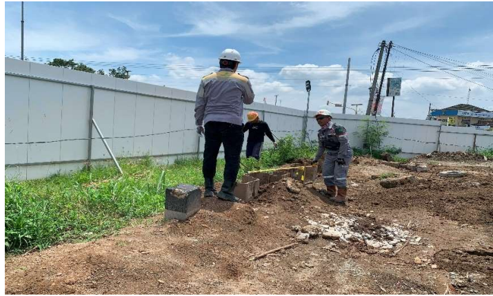
Gambar 4. 3 Pekerjaan marking area pancang
