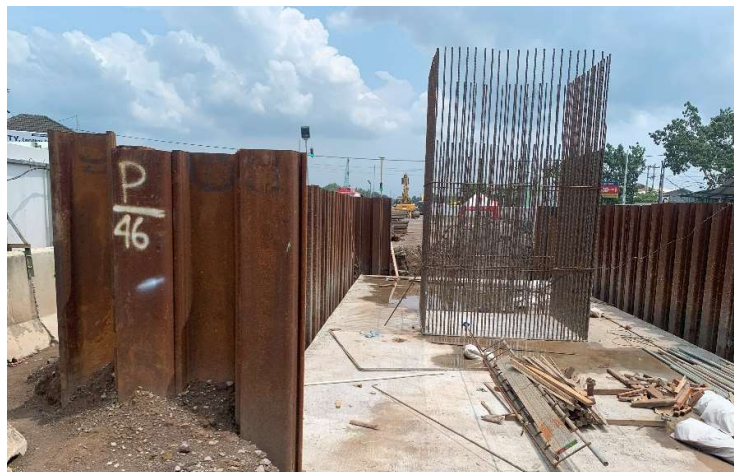
Gambar 4. 6 Pekerjaan Tulangan dan Pengecoran Pile Cap
