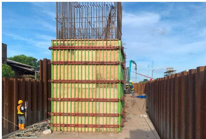
Gambar 4. 7 Pekerjaan tulangan dan pengecoran kolom
