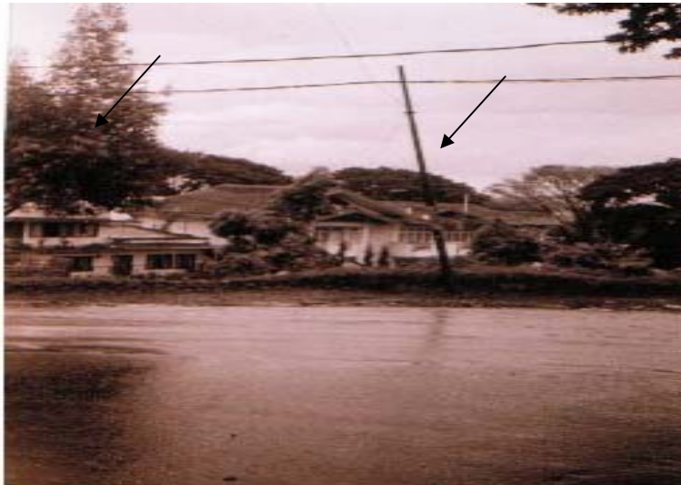
Gambar 4.19. Fenomena Rayapan Tanah Ditunjukkan Oleh Gejala Miringnya Tiang Listrik dan pohon Ditemukan pada Satuan Medan Lereng Tengah Gunungapi Berlereng curam Penggunaan Lahan Prasaran Fisik Jenis Tanah Regosol (V.V.Pf.Reg) di Kecamatan Guguk Panjang.
